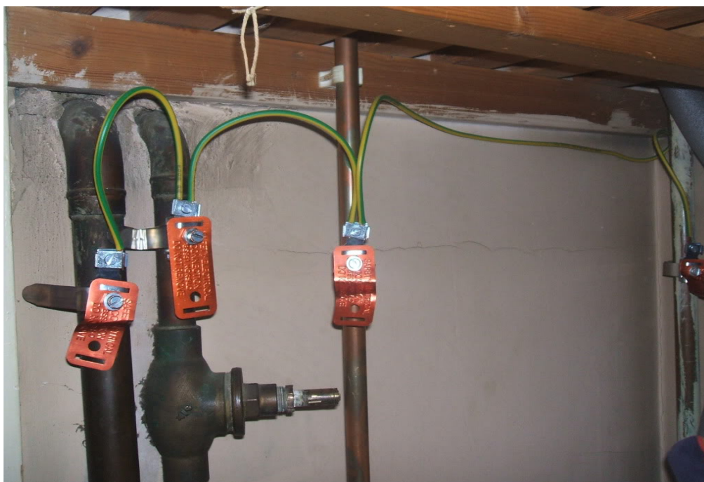
Figur 8, eksempel på beskyttende potentialudligning.
