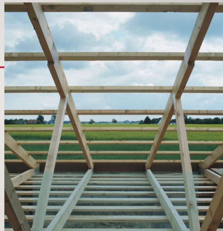
Træspær 1 Spær med hulplader
