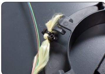
2. Fiberkablet trækafastes ved at kablets kevlar snoes om en fiber guide og låses med en strip. Fiberen konnekteres.
