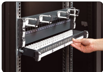
13. Patchpanelet kan nu skubbes på plads igen.
