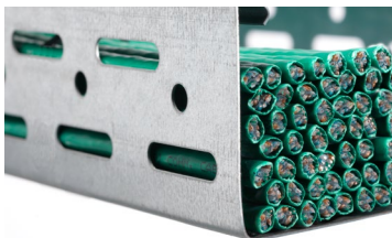
Korrekt anbringelse af kabler i perforeret kabelbakke
