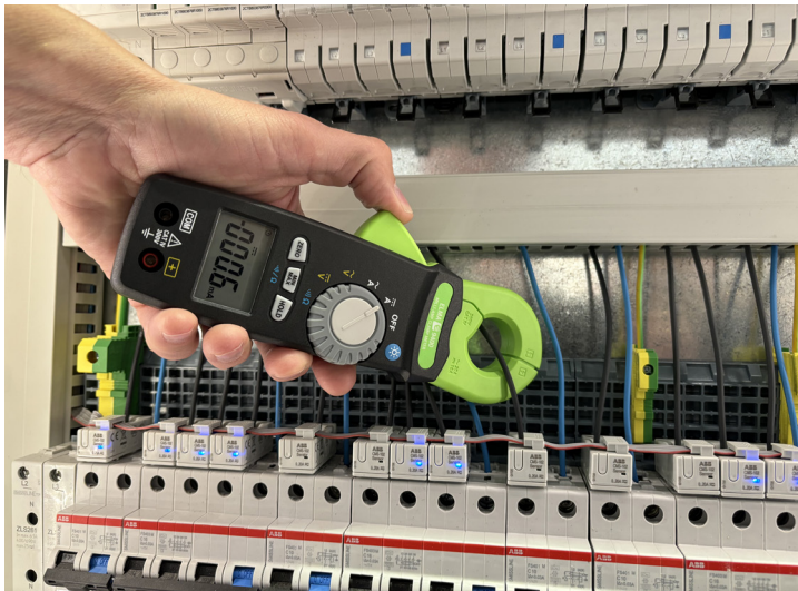
Figur 122: Måling med tangamperemeter
