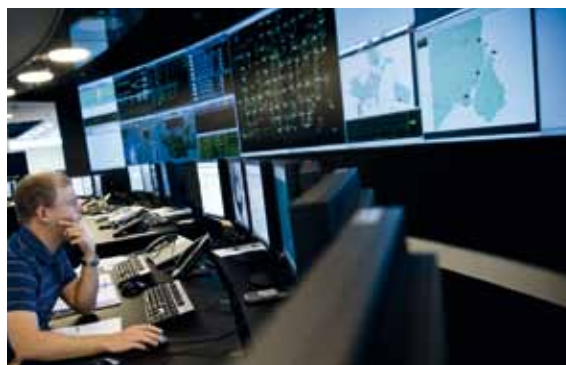
Kontrolrummet hos Energinet.dk
