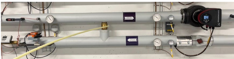
Figur 11: Kontrol af kontraventil i blandesløjfe.
