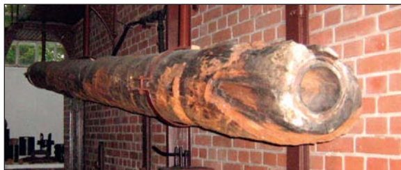
Vandrør i træ fra Aalborg vandforsyning
