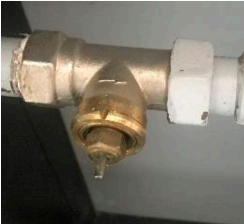
Figur 22. Radiatorventil
