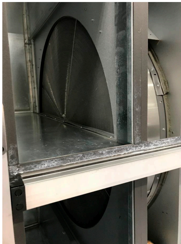
Figur 5. Energieffektiv roterende veksler
