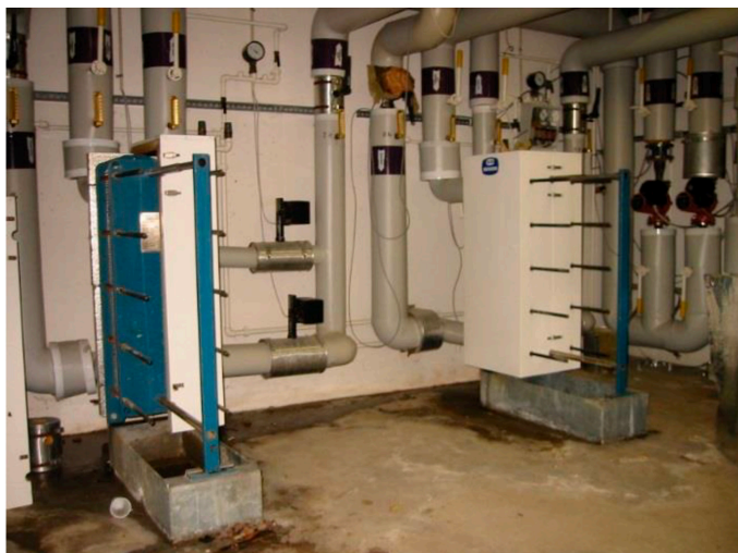
Figur 3. Indirekte anlæg med veksler i etagebolig
