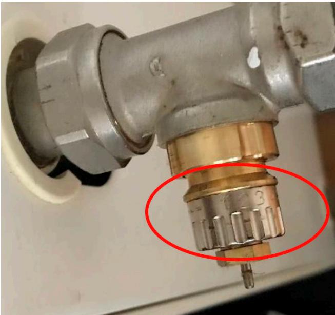
Figur 20. Eksempel på termostatventil med forindstilling (ring der kan indstilles, så radiatoren forsynes med netop den rigtige vandmængde, selv når der skrues helt op for termostaten)
