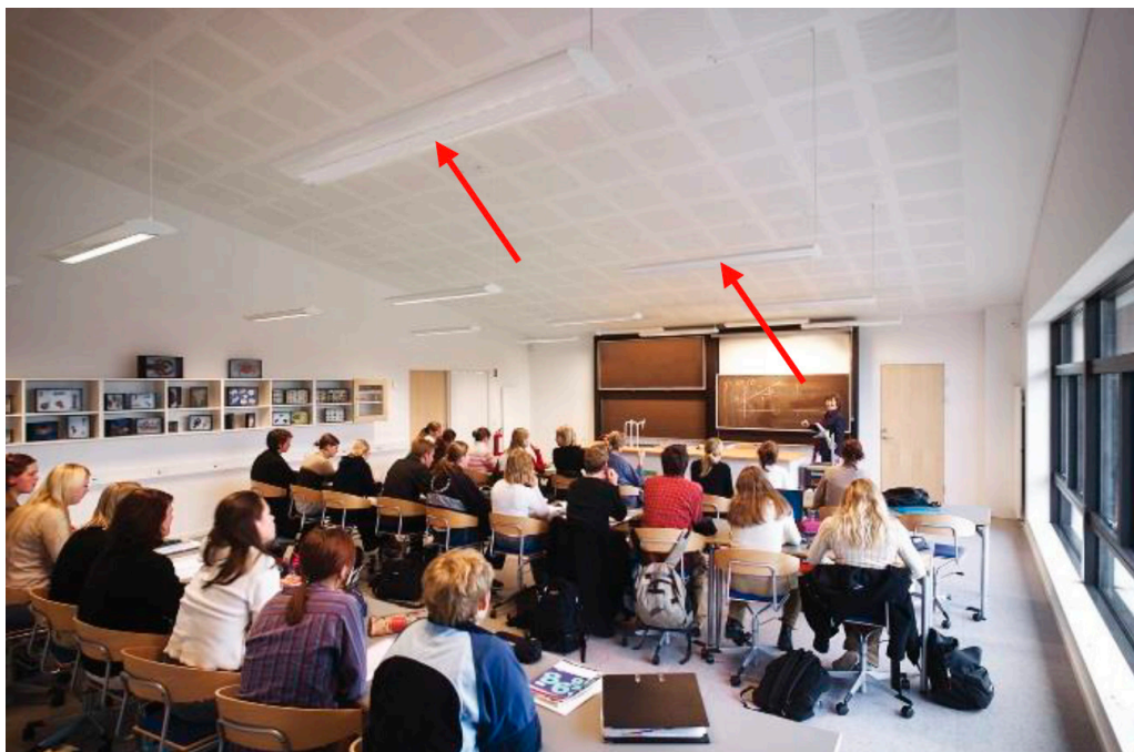
Figur 10. Zoneopdeling af belysningsanlæg. Armaturerne i højre side af lokalet er slukkede mens armaturerne til venstre er tændt. (Kilde: https://installator.dk/store-besparelser-med-lysstyring )
