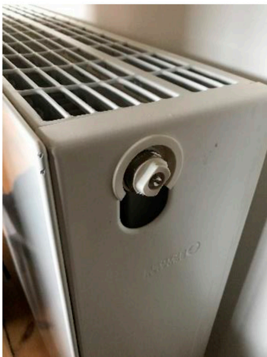
Figur 3. Udluftningsventil
