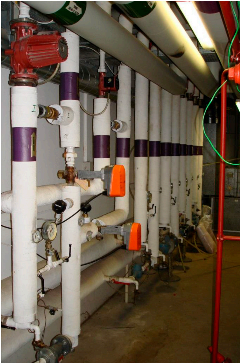
Figur 1. Isolering af rør til radiatorer
