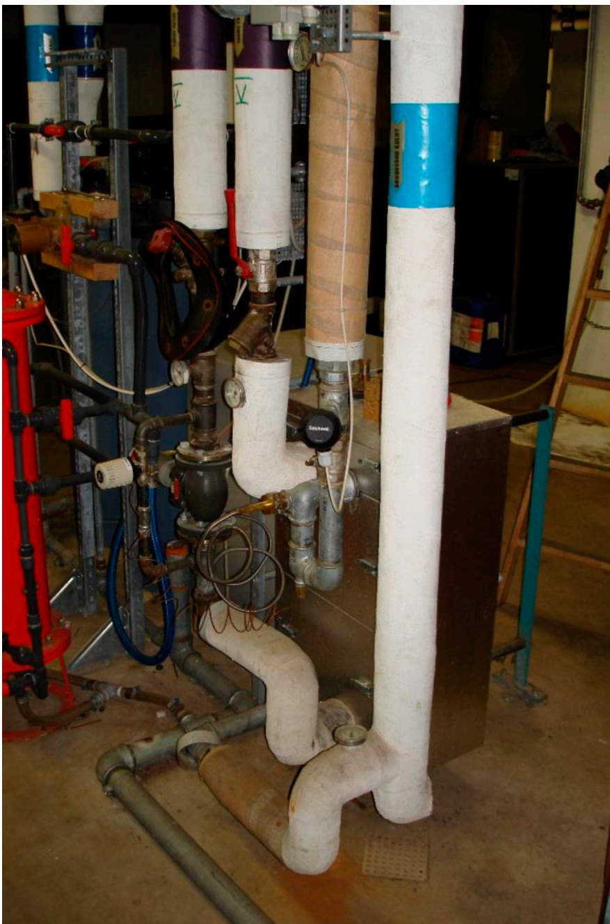
Figur 2. Isolering af rør til varmt brugsvand
