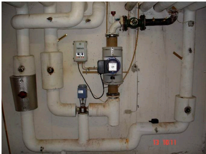
Figur 1. Direkte anlæg med blandesløjfe i etagebolig
