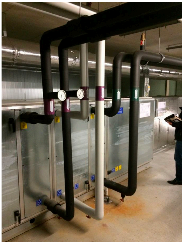
Figur 7. Ventilationsanlæg med køleflade der tilføres koldt vand
