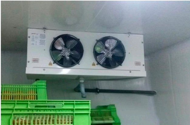
Figur 2. Fordamper (luftkøler)
