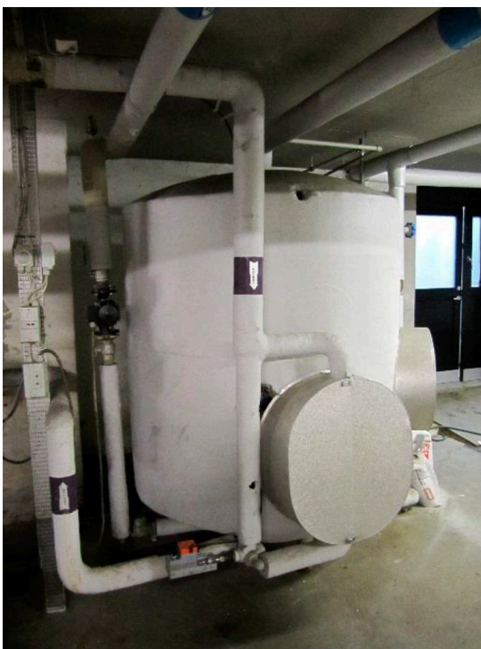
Figur 4. Isolering af varmtvandsbeholder
