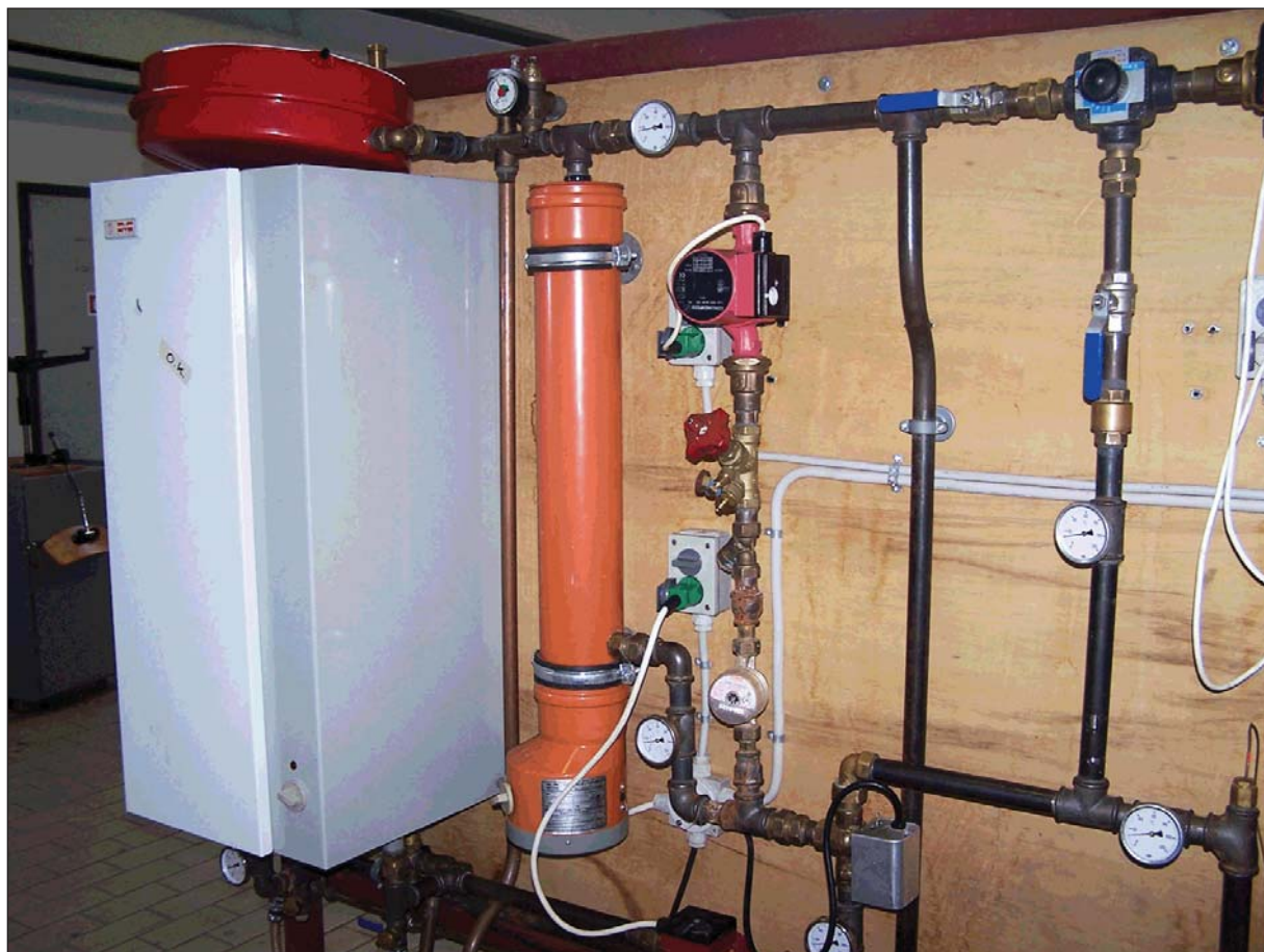
Eksempel på kedelshunt og anlægshunt
