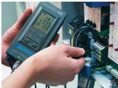
Figur 10.6. Ved måling af effekt anvendes et wattmeter.
