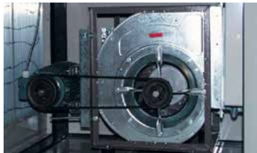
Figur 7.17. Remtrukket ventilator.
