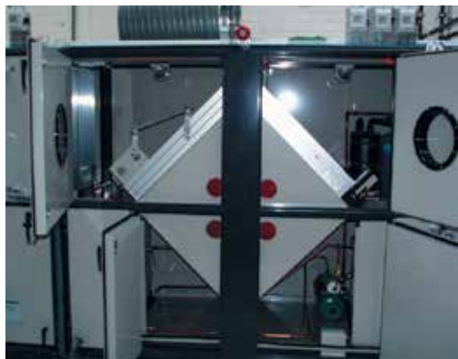
Figur 7.28. Krydsvarmeveksler.
