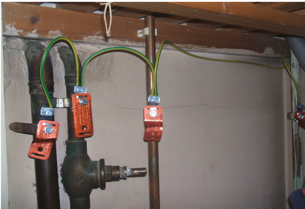
Figur 8, eksempel på beskyttende potentialudligning.
