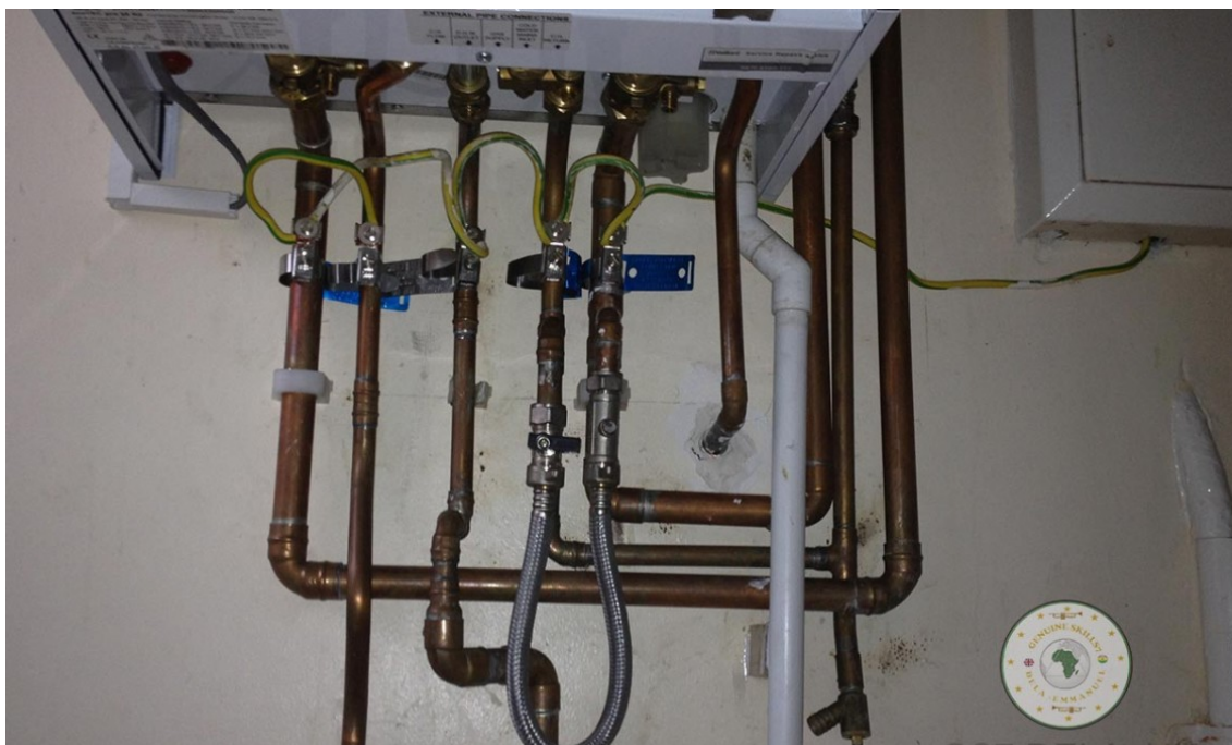
Figur 9, eksempel på beskyttende potentialudligning.
